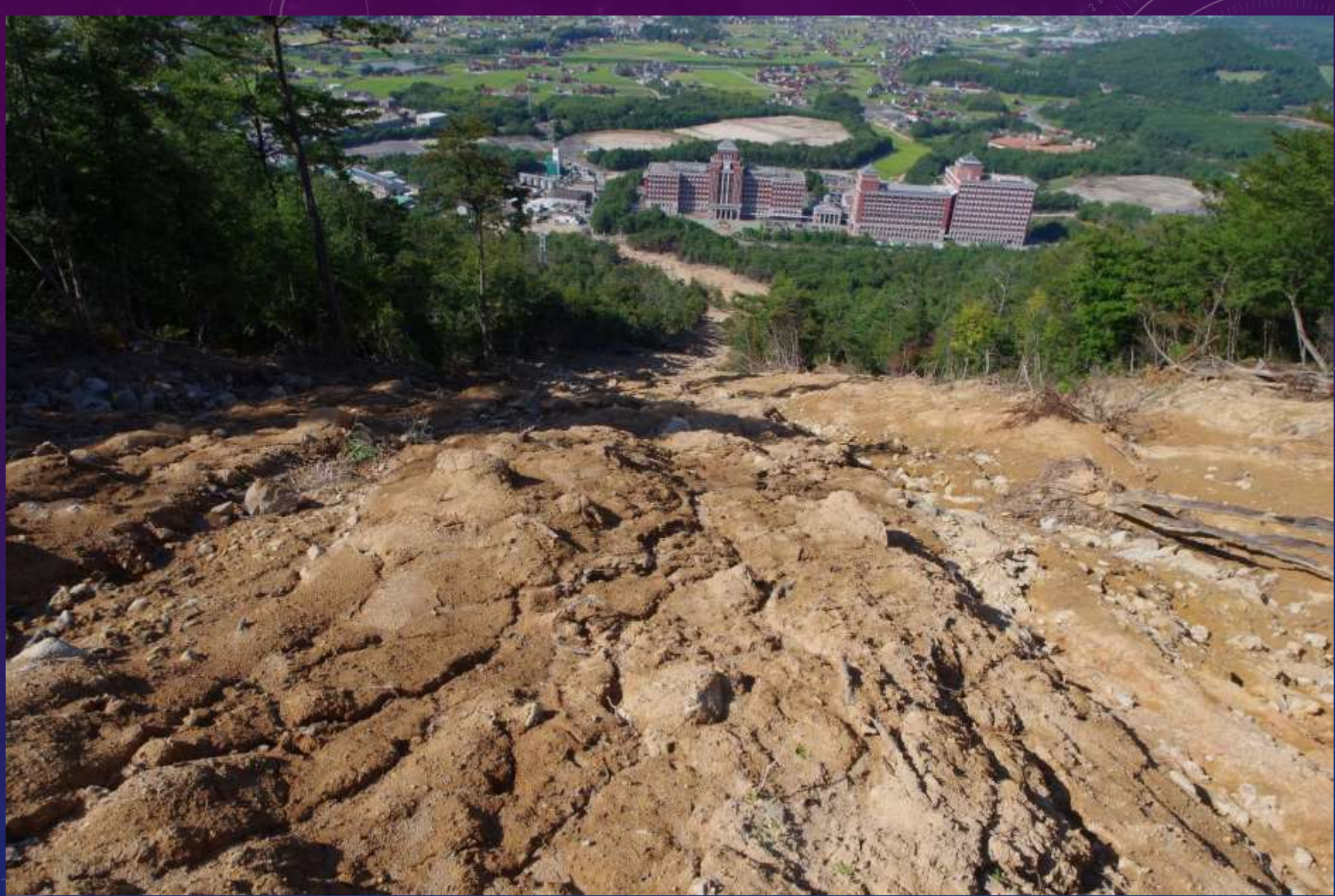
崩壊Bの中腹から下流を撮影 泥質な堆積物(層厚1m程度)が卓越、ガリー侵食を受けている
