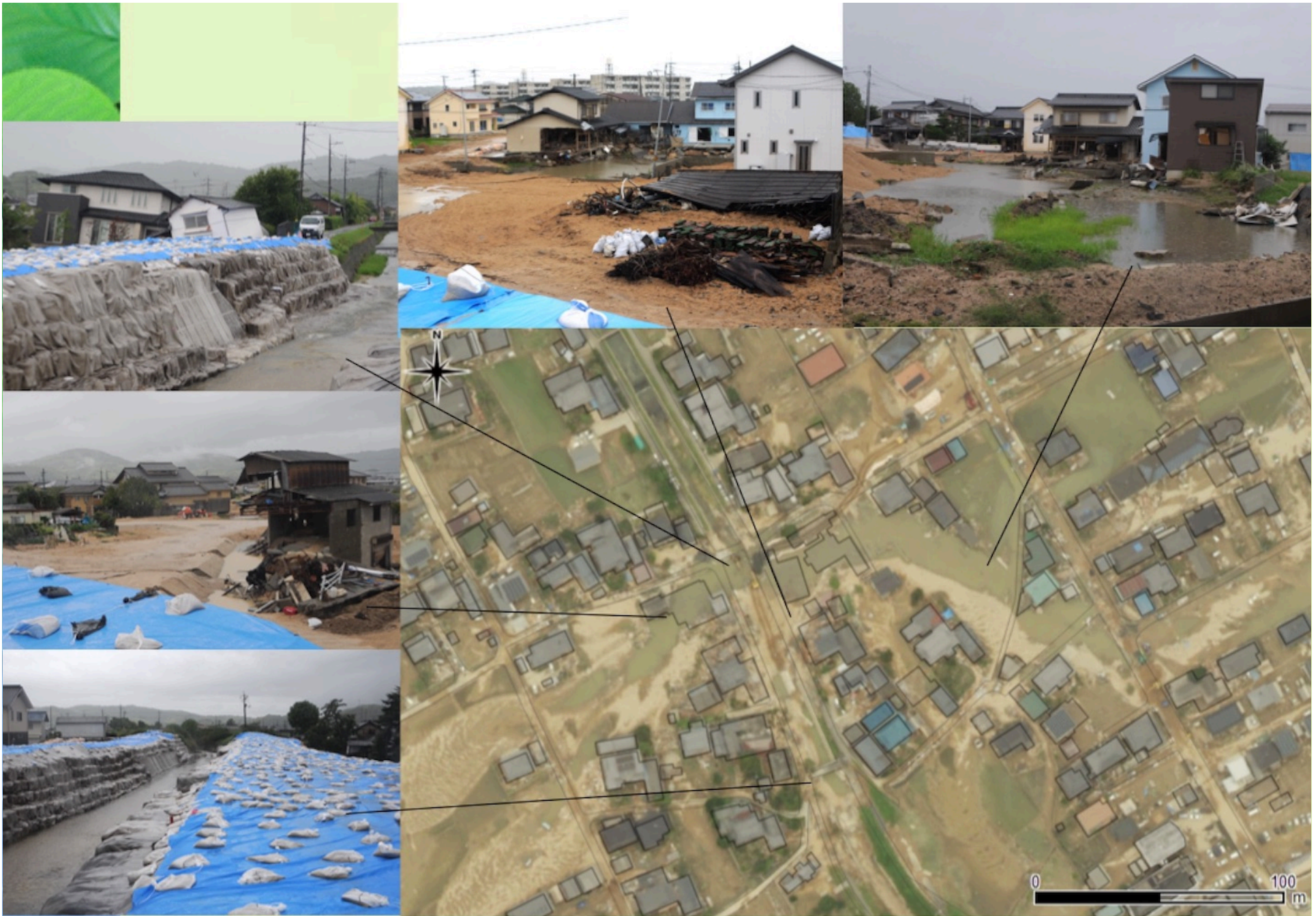
末政川の破堤にともなう建物の変化(建物の外形は基盤地図情報による)
