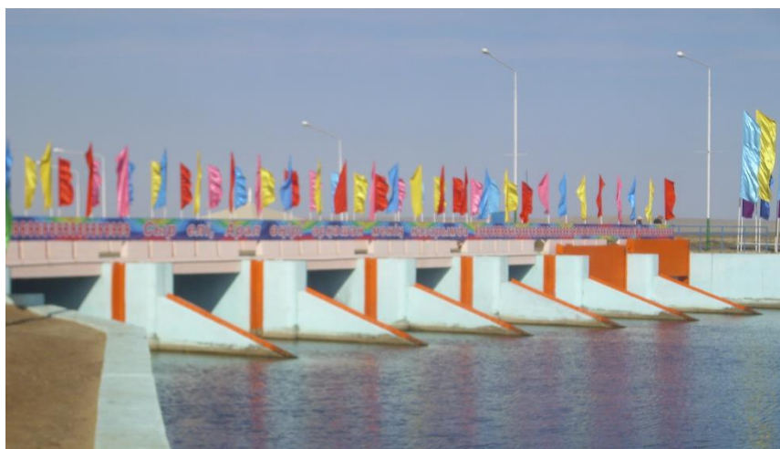
Рисунок 2.6.1. Плотина Северного Аральского моря
