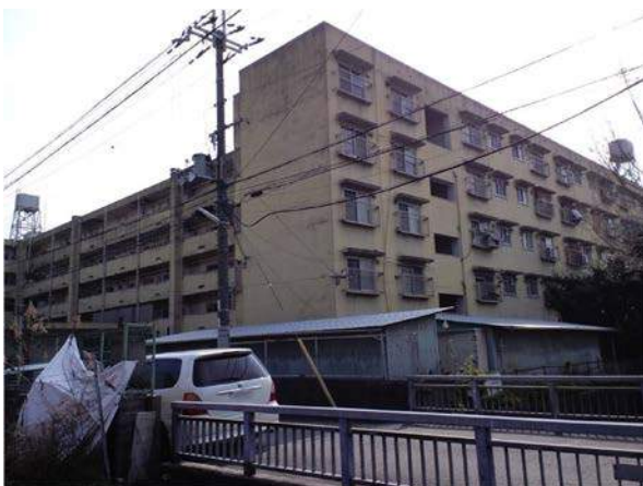
2011年頃、解体前の北河原市営住宅 通称「マンモス団地」
