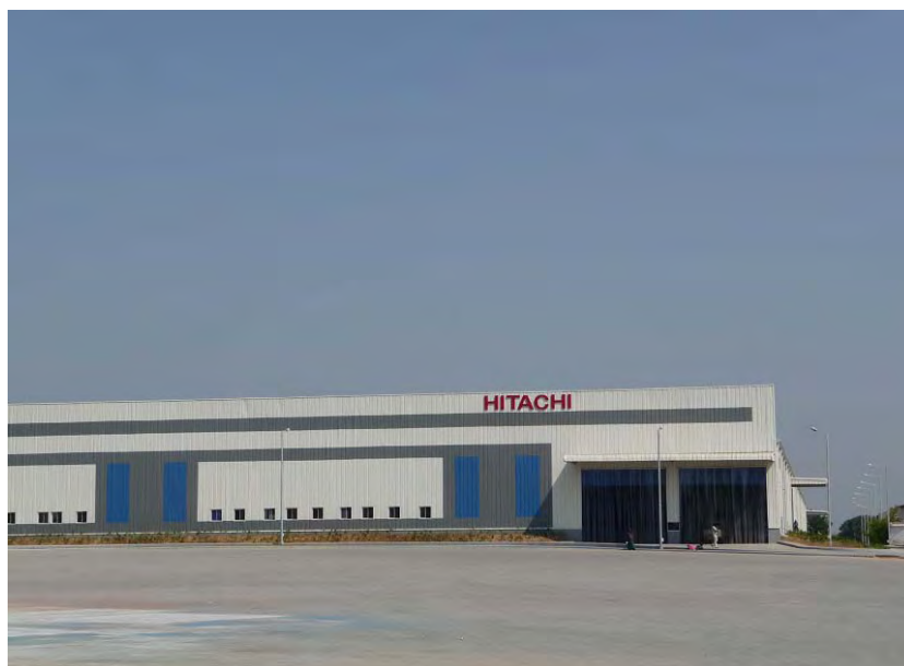
写真7 日立ホームインド 新工場
