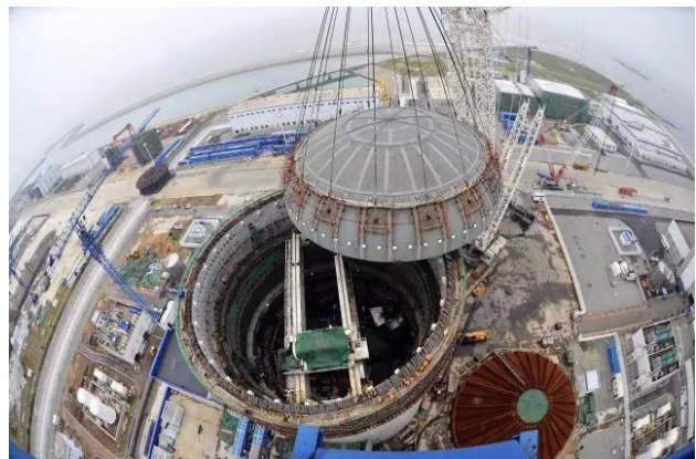
图 5 海阳核电厂 2 号机组钢制安全壳顶封头吊装
