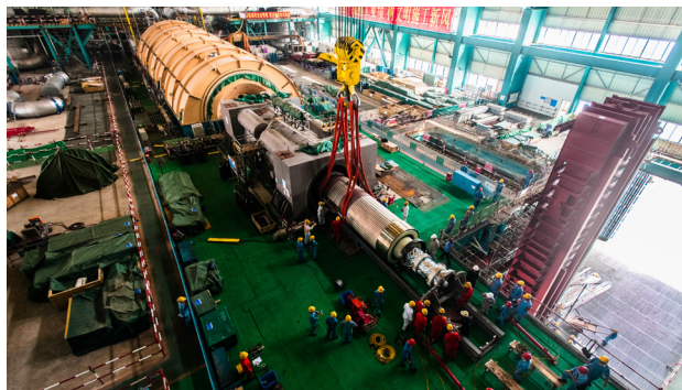
图6 台山核电厂2号机组发电机转子穿装完成
