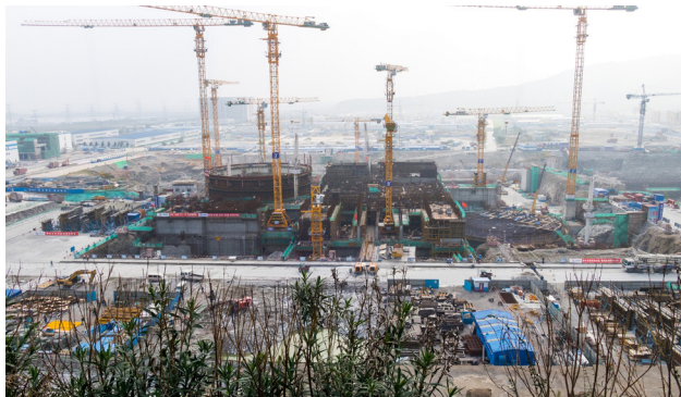
图 1 田湾核电站 5、6 号机组工程进展图
