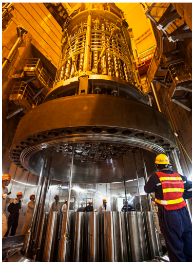
图 16 台山核电厂 1 号机组反应堆压力容器扣盖
