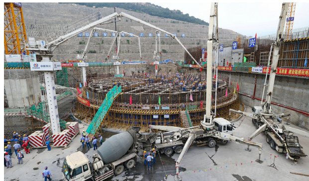
图 2 田湾核电站 6 号机组核岛浇注第一罐混凝土
