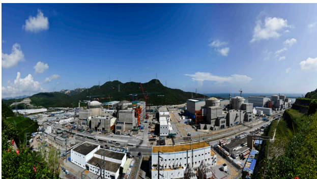
图9 阳江核电厂1~6号机组全景
