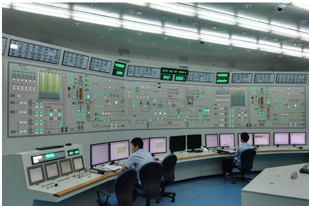
图 18 华能山东石岛湾高温气冷堆核电厂示范工程主控室模拟机
