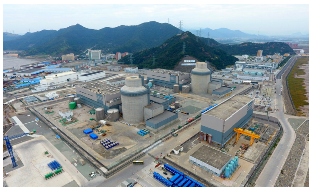
图 15 三门核电厂全景
