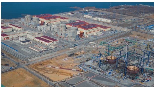
图3 红沿河核电厂1~6号机组全景
