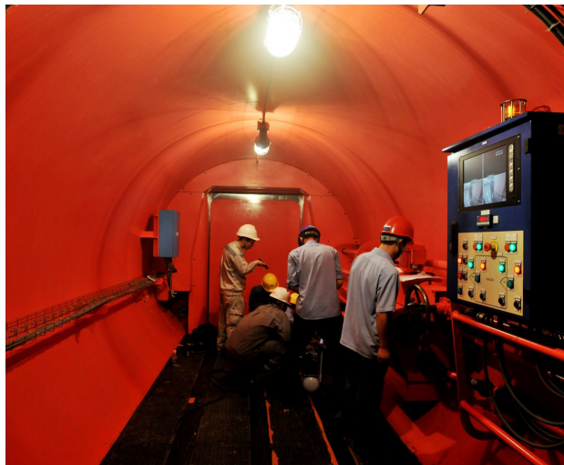
图 17 台山核电厂 1 号机组完成安全壳打压试验
