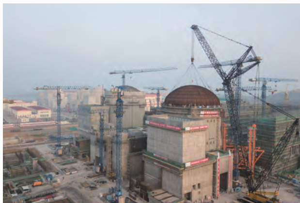
图6 红沿河核电厂6号机组反应堆厂房穹顶吊装成功
