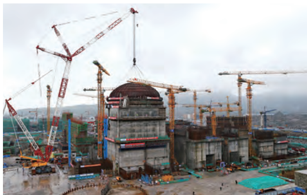
图 3 田湾核电厂 5 号机组安全壳穹顶吊装就位
