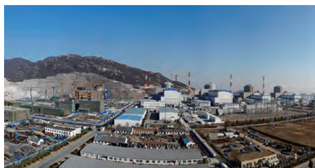
图 2 田湾核电厂 1~6 号机组全景
