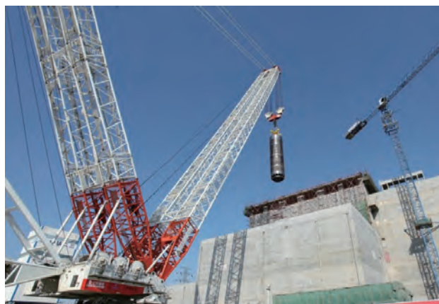
图 18 高温气冷堆核电站示范工程堆内金属构件吊装
