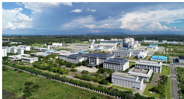
图7 昌江核电厂全景
