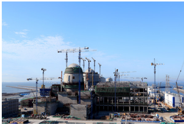
图 5 福清核电厂工程建设现场
