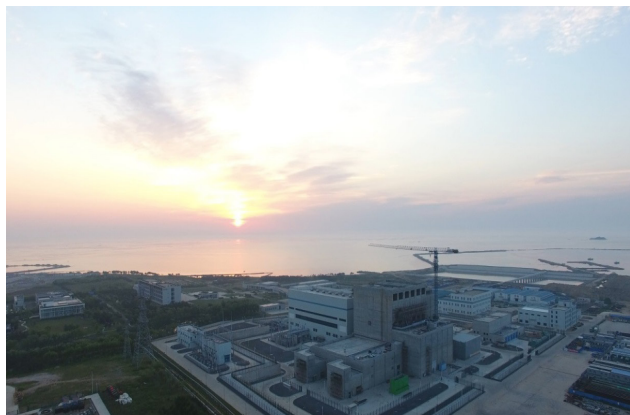
图 9 高温气冷堆核电站示范工程建造现场
