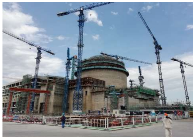
图 12 防城港核电厂3号机组工程建设现场
