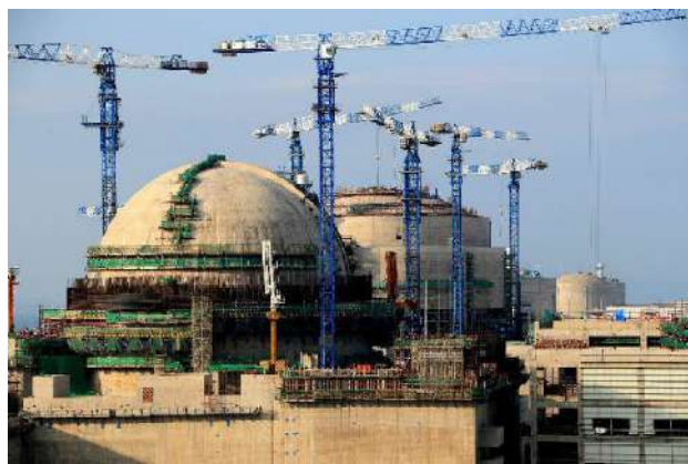
图9 福清核电厂5、6号机组工程建设现场
