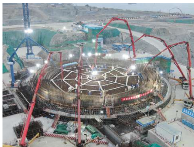
图 20 太平岭核电厂 1 号机组混凝土浇筑现场
