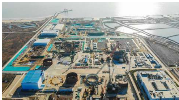
图 17 国核示范工程建造现场
