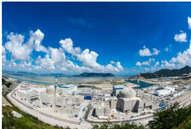
图 15 台山核电厂全景
