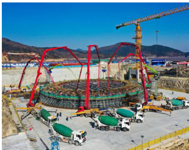
图 17 三澳核电厂 1 号机组混凝土浇筑现场
