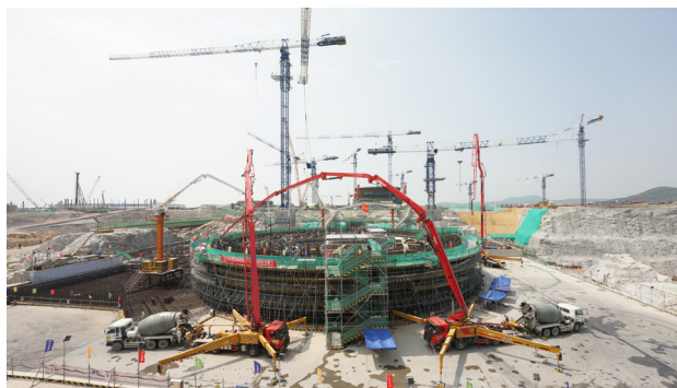
图 13 漳州核电厂 2 号机组混凝土浇筑现场
