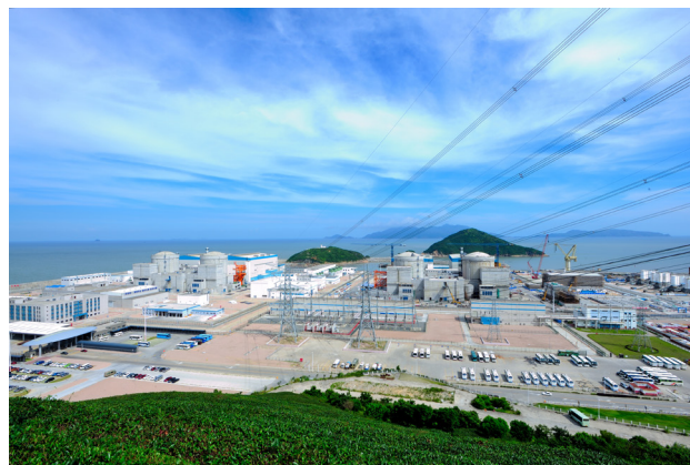
图 5 宁德核电厂 1-4 号机组
