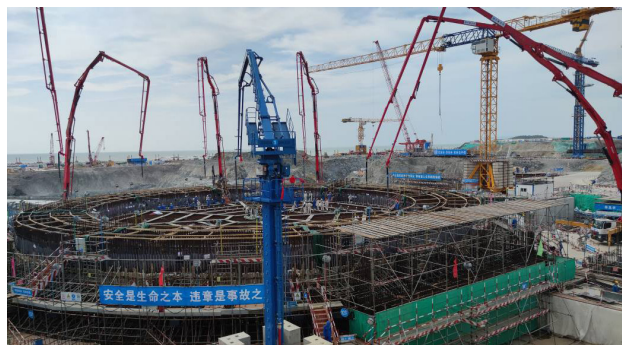
图 15 太平岭核电厂 1 号机组混凝土浇筑现场
