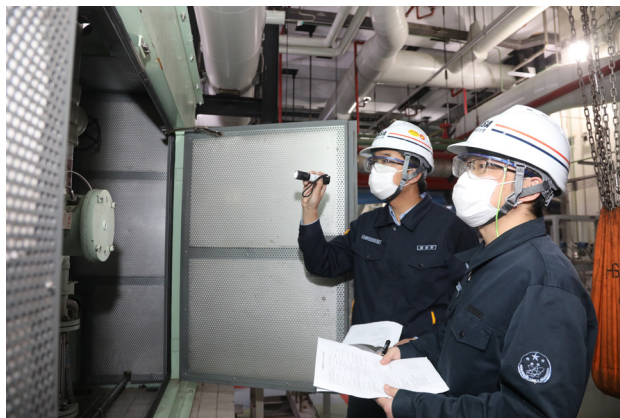
图10 监督员对三门核电厂重要厂房进行巡视
