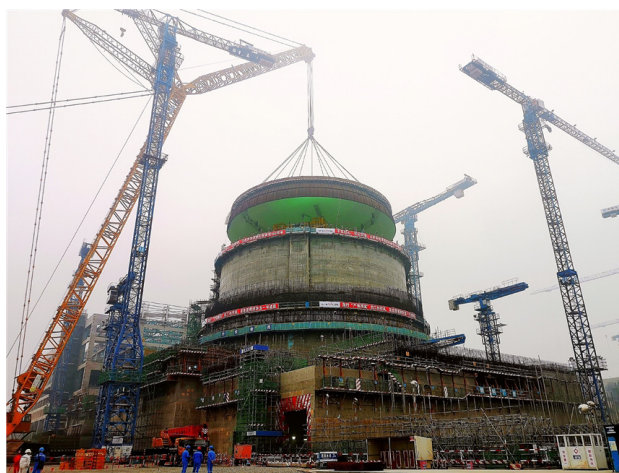
图 9 防城港核电厂 4 号机组穹顶吊装现场
