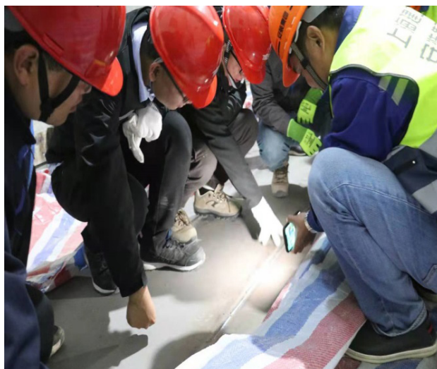
图19 监督员对钍基熔盐实验堆核设备焊接活动进行检查
