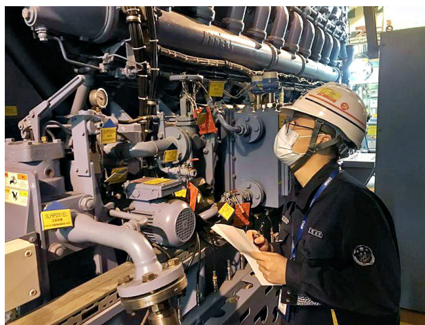
图 8 监督员在福清核电厂柴油机房巡视
