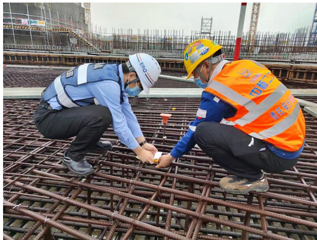
图 10 监督员在三门核电厂 3 号机组核岛基础浇筑第一罐混凝土前开展钢筋取样见证
