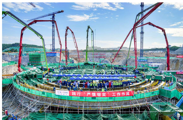
图 18 陆丰核电厂 5 号机组混凝土浇筑现场
