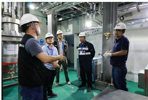
图19 2MWt 液态燃料钍基熔盐实验堆监督现场
