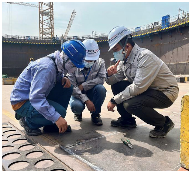
图5 田湾核电站8号机组钢衬里底板焊缝埋弧焊接质量监督
