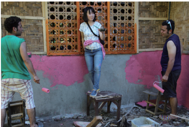
建設中の保育所のペンキ塗りも手伝った
