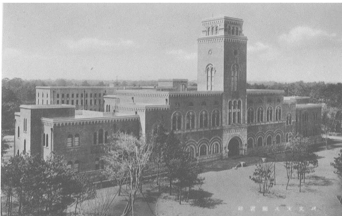
研究室及図書館（現・図書館時計台棟） / 国立移転記念絵はがき（昭和6年）
