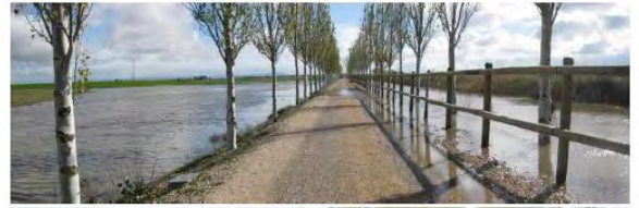
Recrecido mota canal en la margen izquierda en un tramo de longitud 1.700 metros
