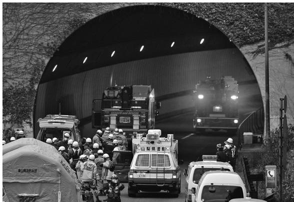
中央自動車道の笹子トンネル崩落事故でインフラの深刻な老朽化が明らかになった（2012年12月）
