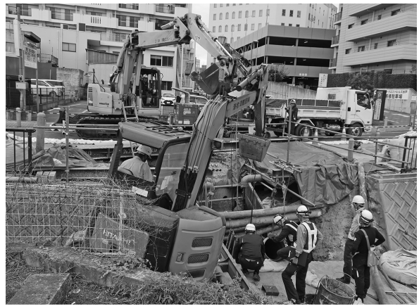
下水道管の破損で陥没した道路の復旧工事（24年10月17日、水戸市）
