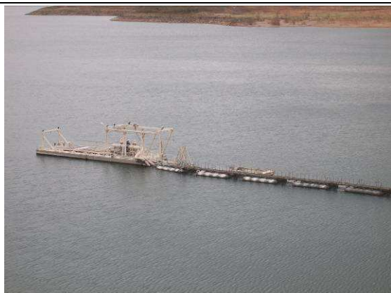
La station de pompage flottante
