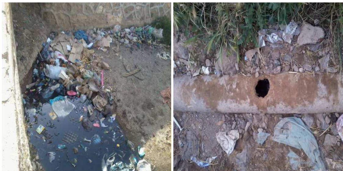
Figure 2 : Rejet des eaux usées brutes sans aucun prétraitement ; regard colmaté
