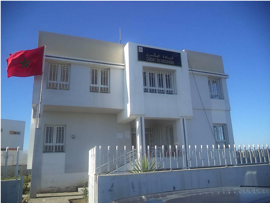
Photo 6 Siège du caïdat de Mograne
