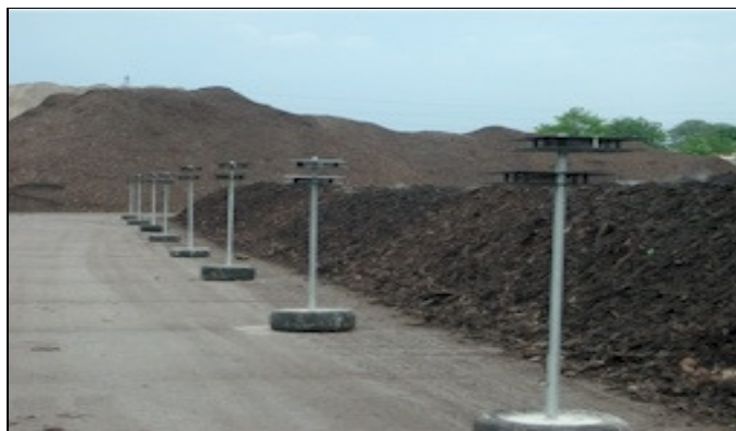
Photo 2 : Exemple de dispositifs de traitement chimique des odeurs
