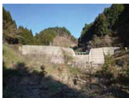
荒廃砂防堰堤 H3竣工 高さ10m
