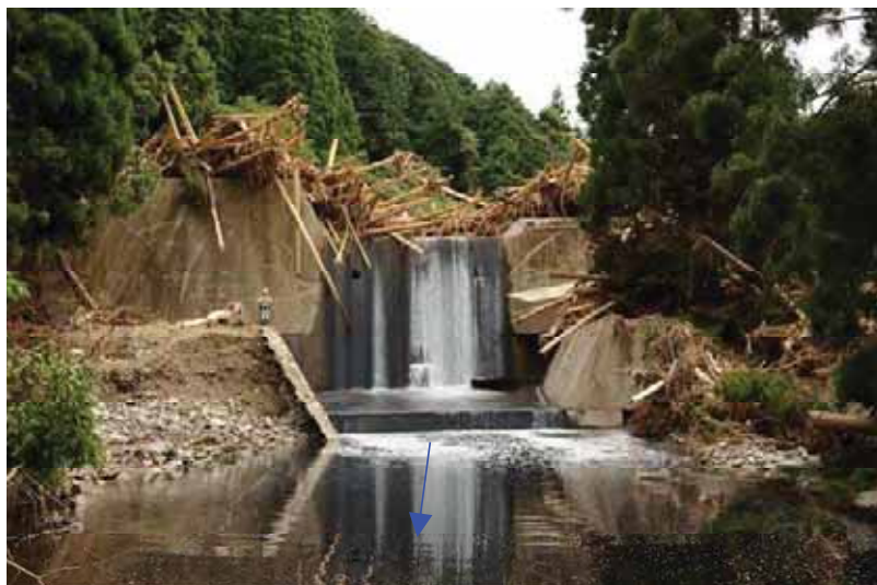
須川第一砂防堰堤下流から本堤を撮影
