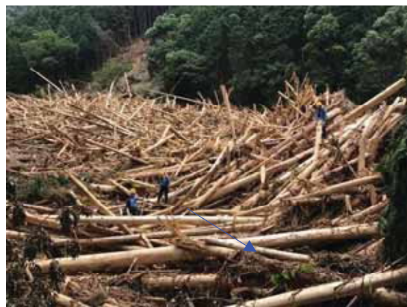
須川第一砂防堰堤堆砂域に堆積した流木を撮影
