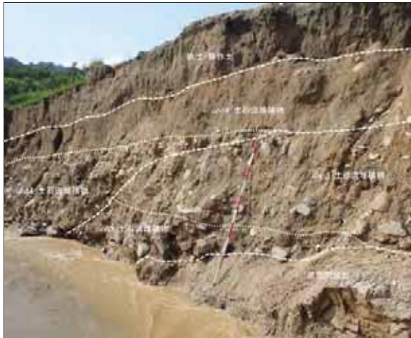
乙石川0k200付近の崩壊面に見る過去の土石流堆積物 【速報】平成29年7月九州北部豪雨災害 赤谷川～乙石川で発生した土石流・土砂流堆積物の特徴, 応用地質学会」より引用
