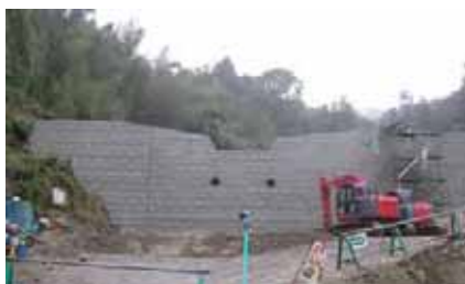
大山川2号砂防堰堤 H21竣工 高さ10.5m
