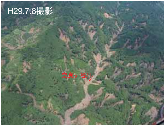
奈良ヶ谷川上流の崩壊状況(変成岩類が主)
