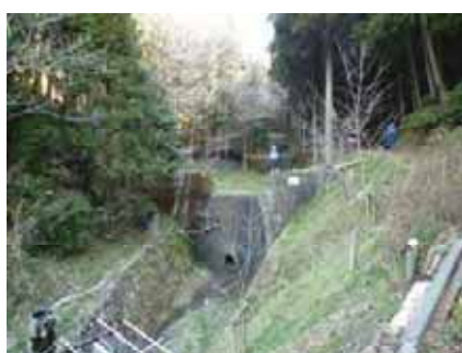
馬の谷砂防堰堤 S48竣工 高さ5m
