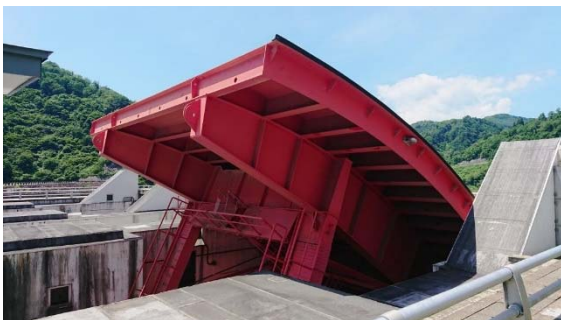
ダム天端から見える非常用洪水吐全開の様子（平成30年7月点検時）
