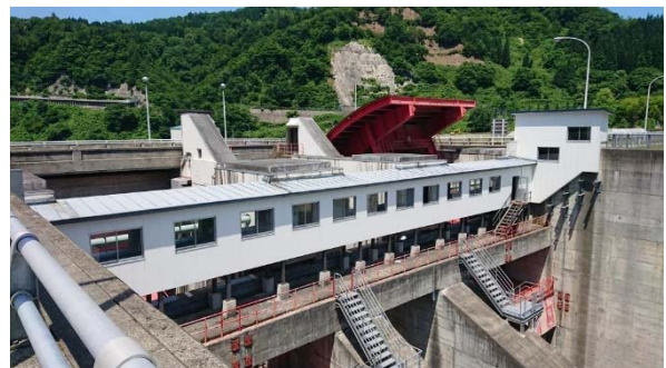
ダム天端から見える非常用洪水吐全開の様子（平成30年7月点検時）
