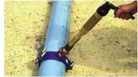
Máquinas de taladrado y roscado con tuerca y yugo de avance
