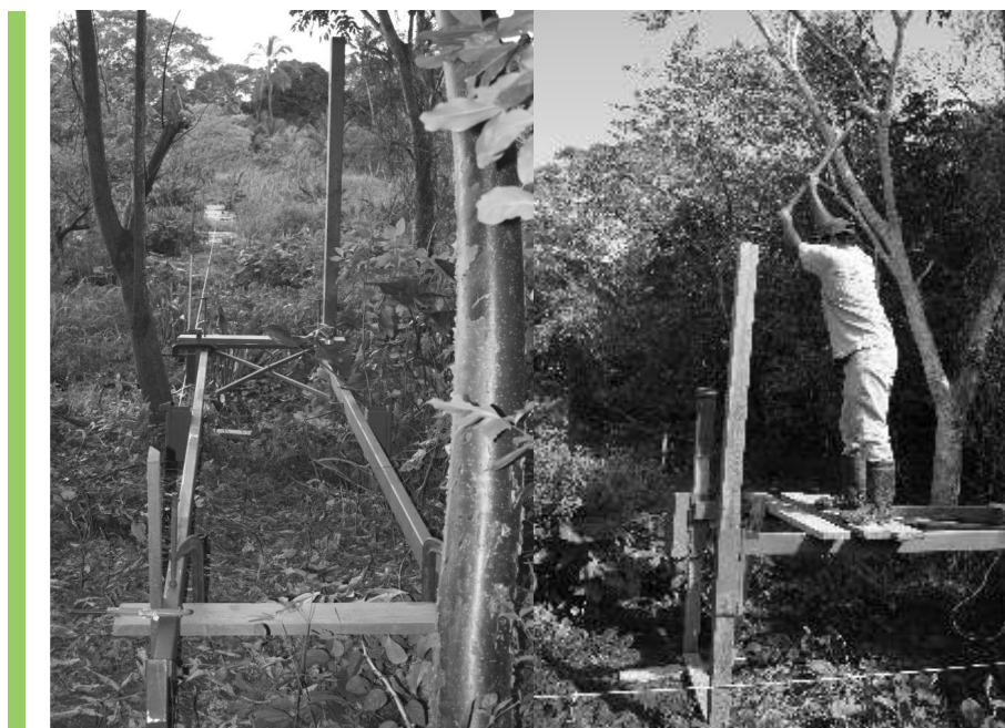
Figura 3. Imagen a la izquierda: vista general de la plantilla metálica. Imagen a la derecha: colocación de polines o postes en un humedal.
