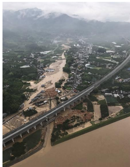
写真-4 北川本陣橋の大規模な流木集積による氾濫の状況 (平成 29 年 7 月 6 日撮影)
