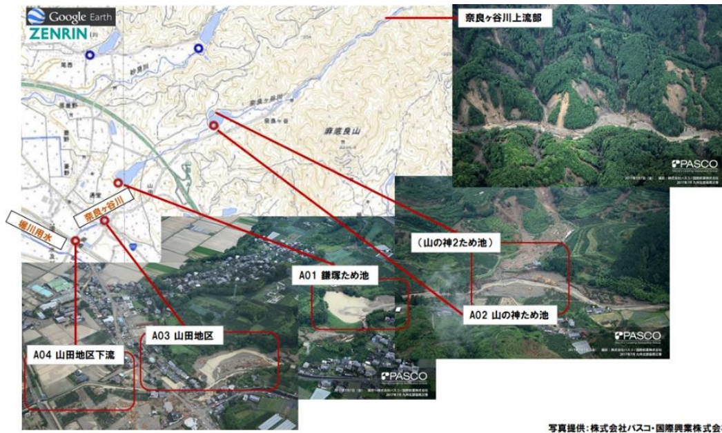
図-6 奈良ヶ谷川流域被災後航空写真
