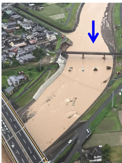
写真-2 花月川の JR 橋倒壊 (平成 29 年 7 月 6 日撮影)
