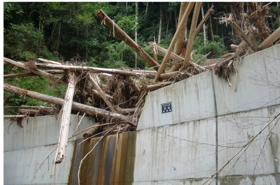
写真-4 林地・溪岸浸食の事例（朝倉市）と堰堤の効果事例（東峰村）
