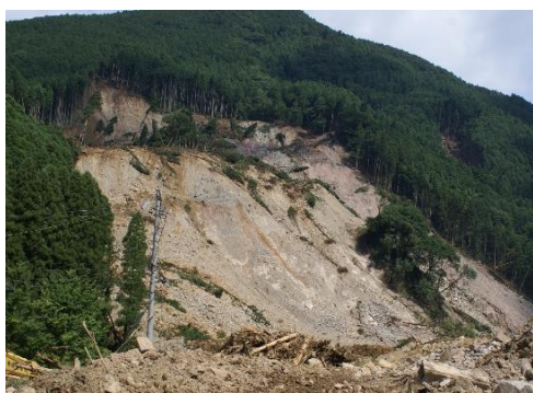
写真-3 花月川上流小野川の大規模斜面崩壊 (平成 29 年 7 月 14 日撮影)
