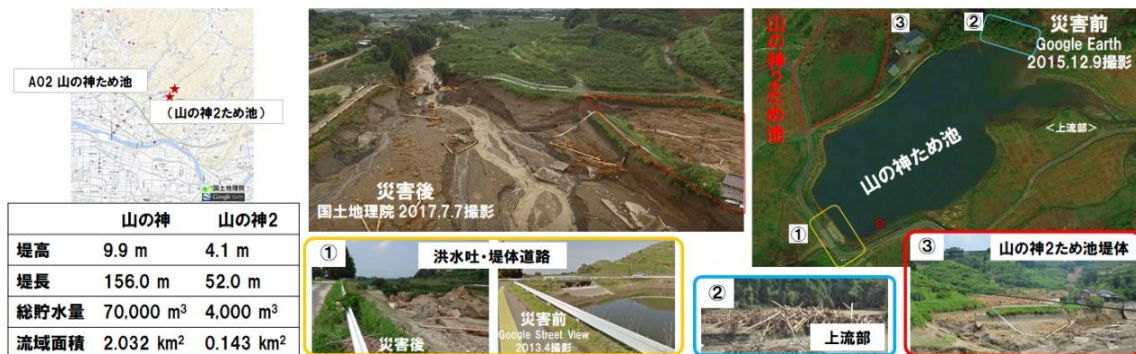
図-7 山の神ため池・山の神2ため池調査写真
