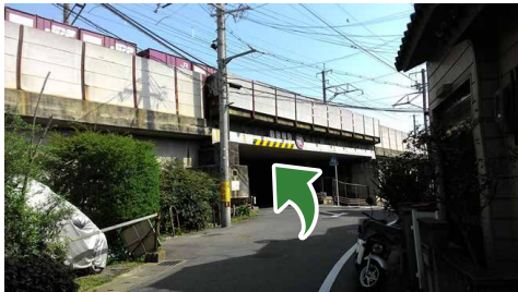
③ 通過 JR 的高架橋
