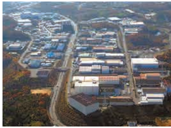
交通結節点の立地を生かし岡山市と早島町にまたがって整備された岡山県総合流通センター
