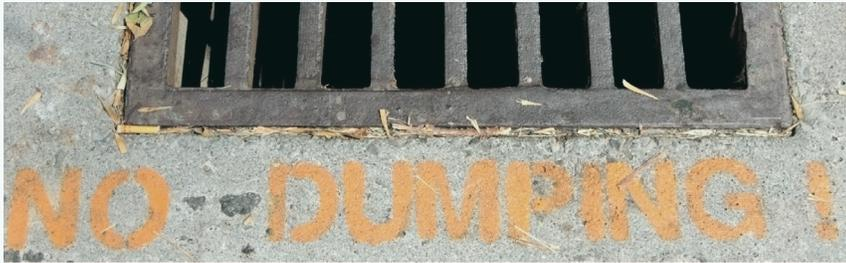
**暴風雨水系統**只輸送雨水和融雪。雨水管道未經處理就會流入溪流、河流、地下水和普吉特海灣。允許雨水或融雪以外的任何東西進入雨水管道是違法的，並可能會導致罰款和昂貴的清理費用。您應該假設所有室外排水管都會流向雨水系統，並且只能允許雨水進入這些系統。有關雨水系統的問題，請致電您物業所在的城市並詢問暴風雨水部門。如果您在非金郡管轄區，請致電 **206-477-4811**。
