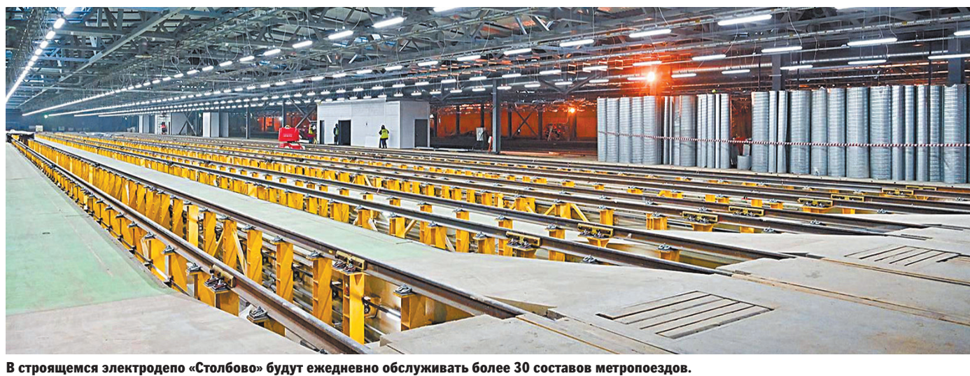
В строящемся электродепо «Столбово» будут ежедневно обслуживать более 30 составов метропоездов.
