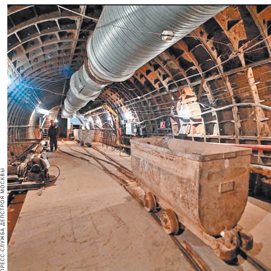
Строительство станции метро «Достоевская» ведется без использования проходческих комбайнов и остановок движения по Кольцевой.
