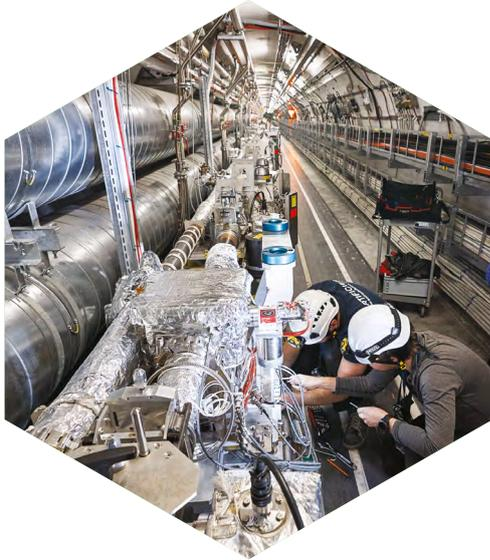
Installation d'un nouveau collimateur à cristaux dans le LHC pour réaliser des tests *in situ* durant l'exploitation avec des ions plomb.
