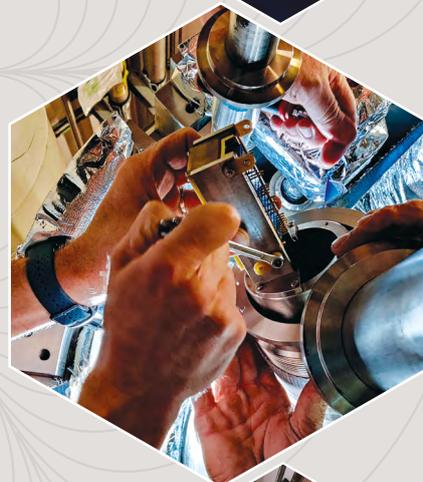
*(Image centrale) Le soufflet défectueux est remplacé. Les experts insèrent l'instrumentation dans le nouveau soufflet.*
