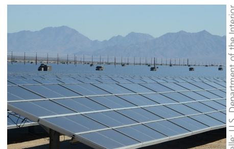
Abbildung 25: Photovoltaikanlage „Desert Sunlight“ mit einer Leistung von 550 MWp in der Mojave-Wüste in Kalifornien, USA.
