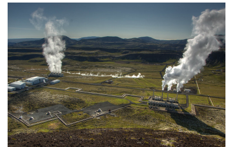
Abbildung 29: Nesjavellir-Geothermieanlage in pingvellir in Island.
