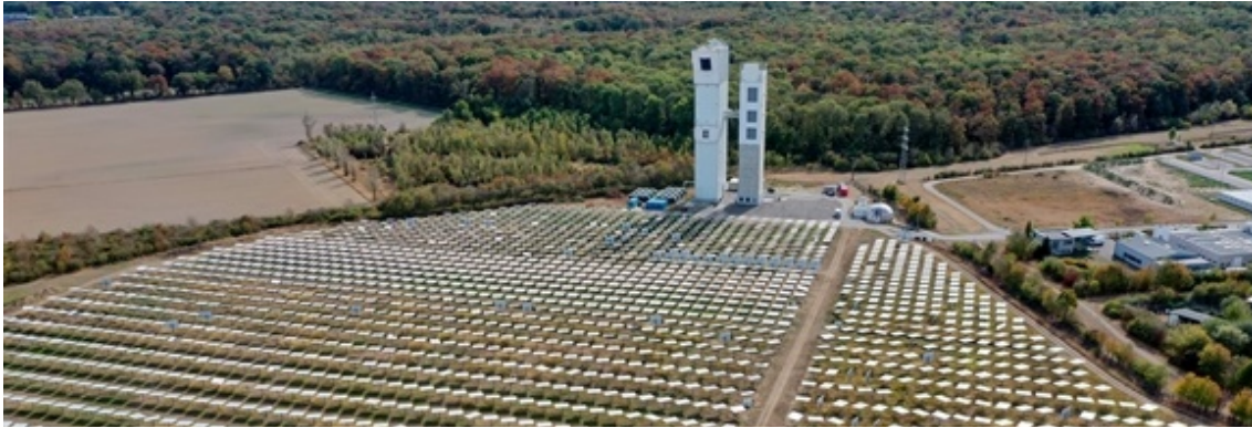
Abbildung 1-5: Versuchskraftwerk Jülich mit Multifokusturm(rechts), Solarturm (links) und Heliostatenfeld (Quelle: DLR (CC-BY 3.0))
