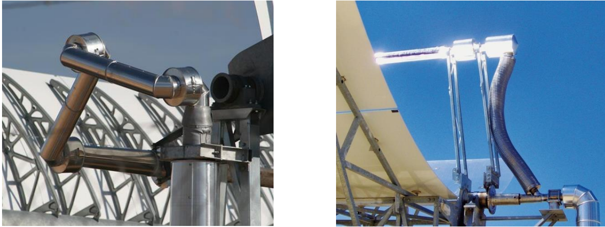
Figura 11. Modelos de interconectores. Junta de bolas (izq.) y manguera flexible (der.) [6].
