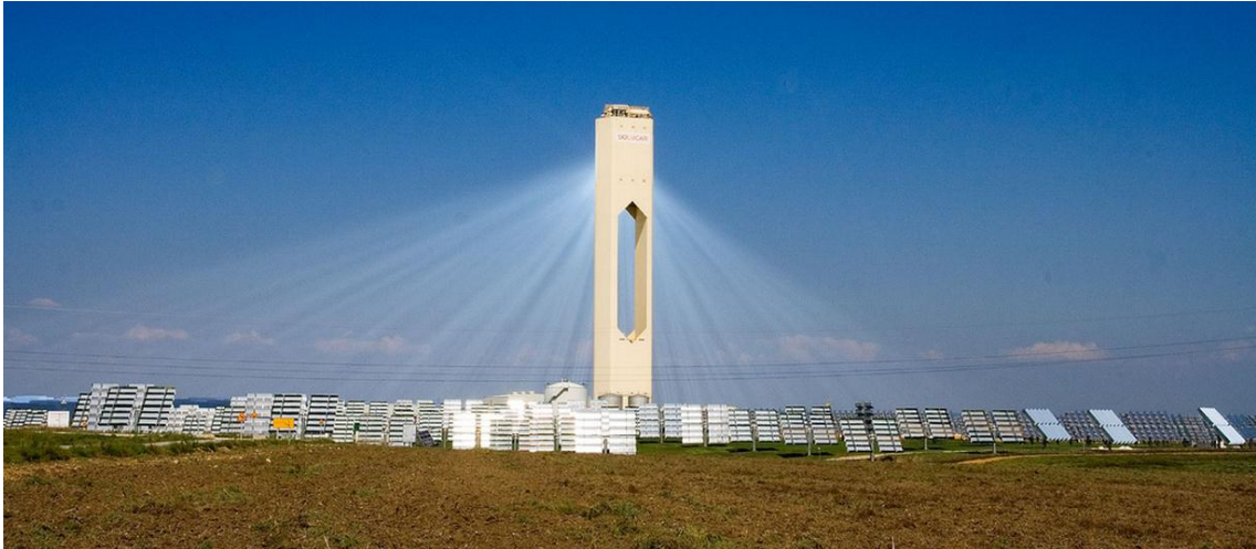
Abbildung 3.4: Solarturm-Kraftwerk PS 10 in der Nähe von Sevilla (Bildquelle: ecofuture.net)
