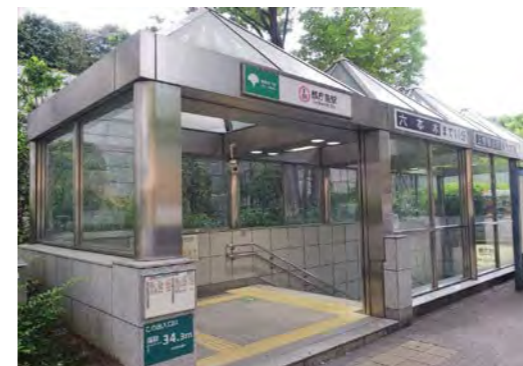
地下鉄出入口
