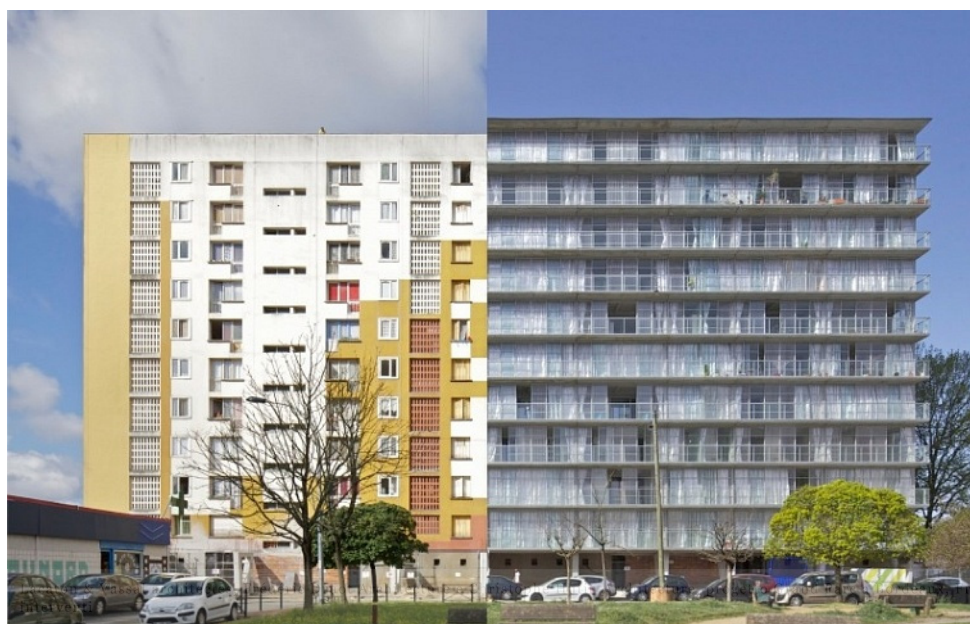
...cia: edifici G, H, I, facciata sud prima e dopo gli
