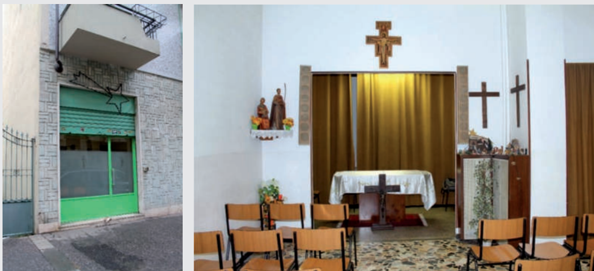
Fig. 5.25 Vista esterna e interna della chiesa.
