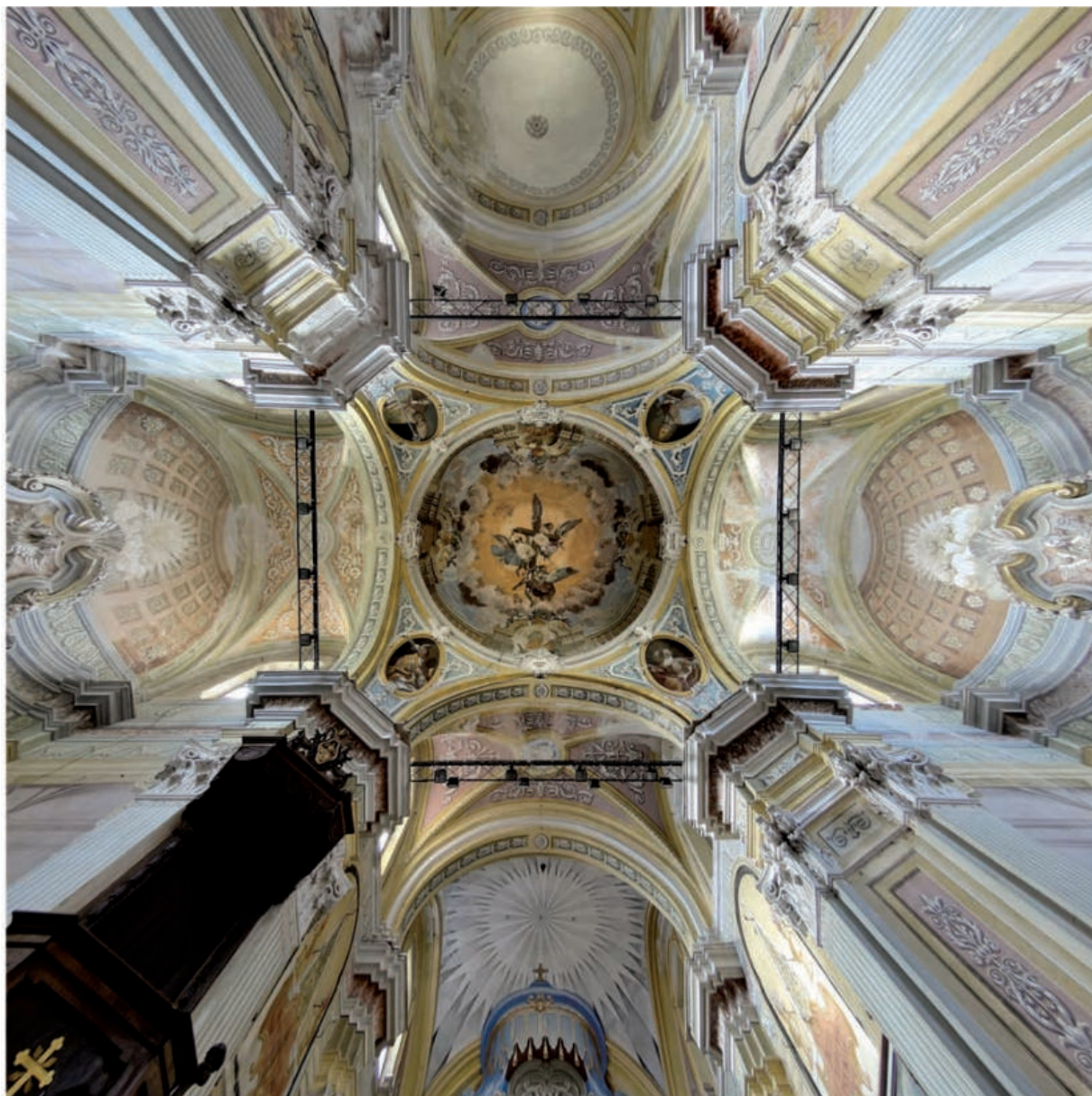
Fig. 13.3 Chiesa di Sant'Ilfredo a Cherasco, particolare delle volte. Foto dell'autore (2020).
