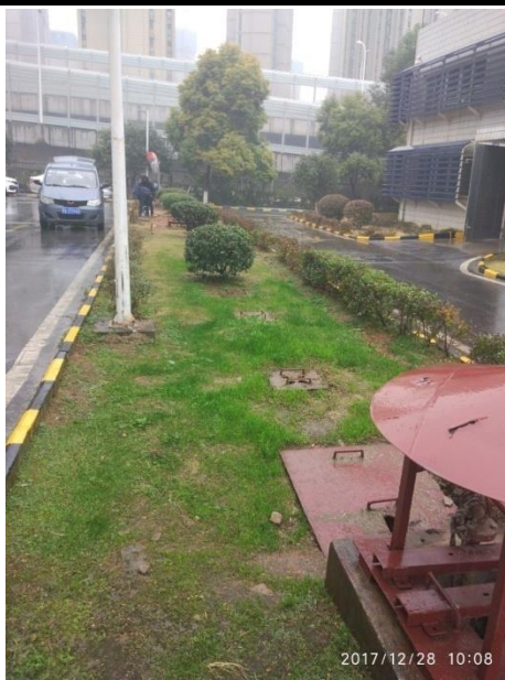
生活污水处理站
