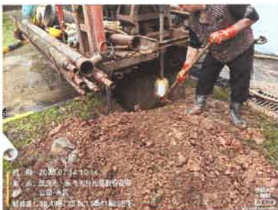
图 4: ▽4#南厂区危化品仓库(6#建筑北侧)旁
