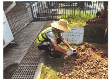
图 6: ▼2#北厂区危化品仓库(302#建筑北侧)旁
