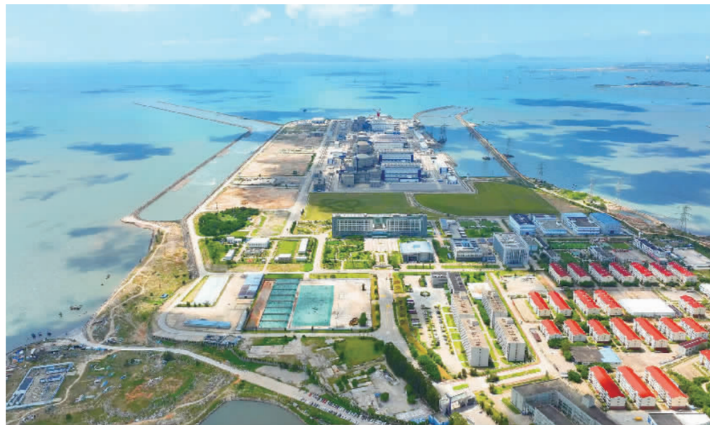
▲图为福清核电“华龙一号”示范工程。
