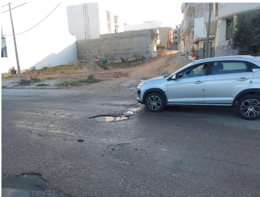
Figure 18:Nids de poule au niveau de la route régionale 857 à Sayada
