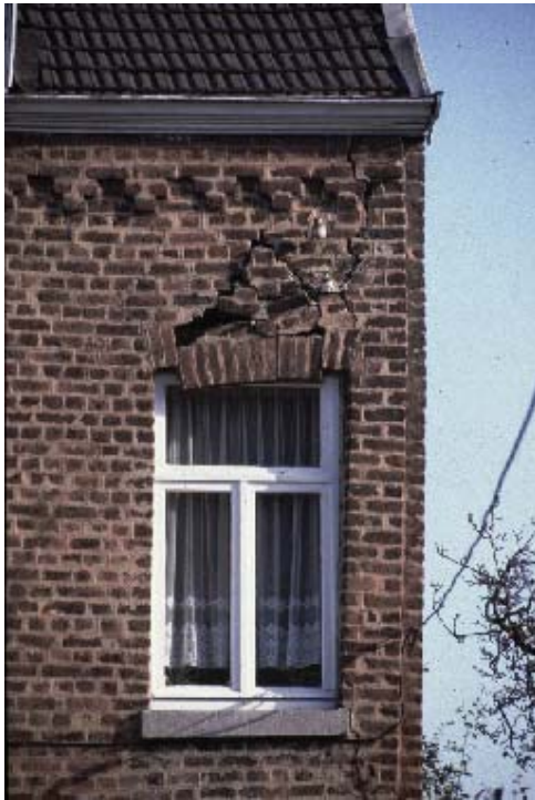
Figure 2.4.15. Décrochage de façade à une ouverture.
