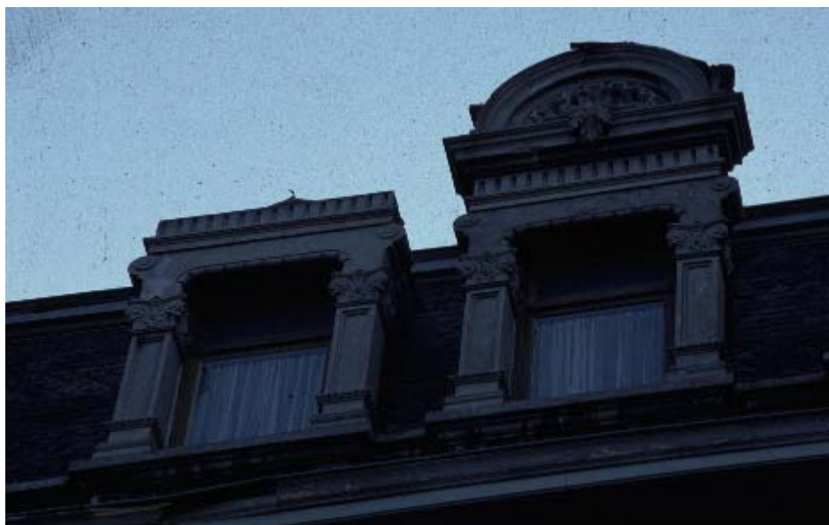
Figure 2.4.19. Le fronton de gauche a basculé...voir l'effet à la figure suivante...
