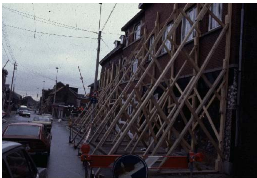
Figure 2.4.7. Stabilisation des façades après tremblement de terre (Liège, 1983)
