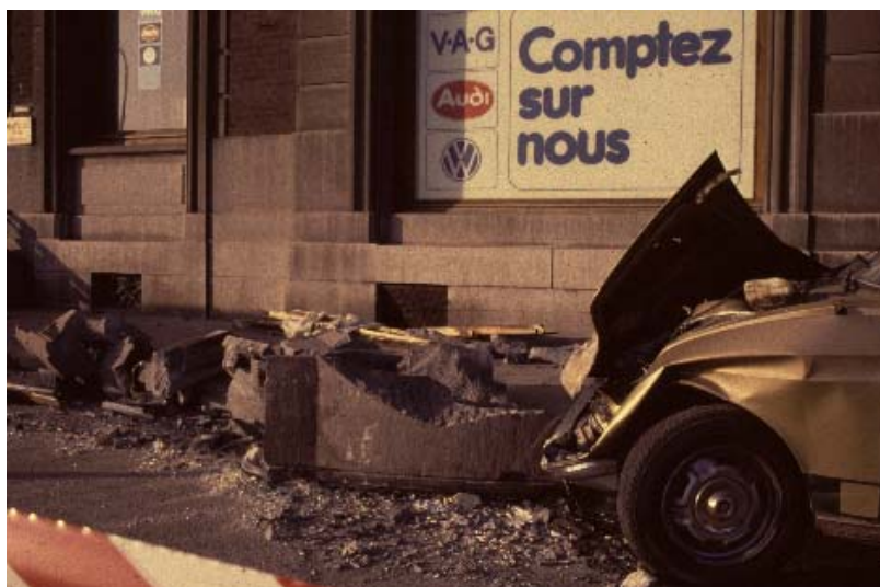
Figure 2.4.21. Chute de pierres au Quai de Rome (Liège, 1983)
