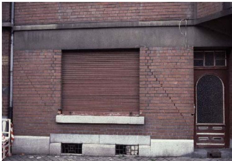
Figure 2.4.11. Fissurations de cisaillement (Liège, 1983)
