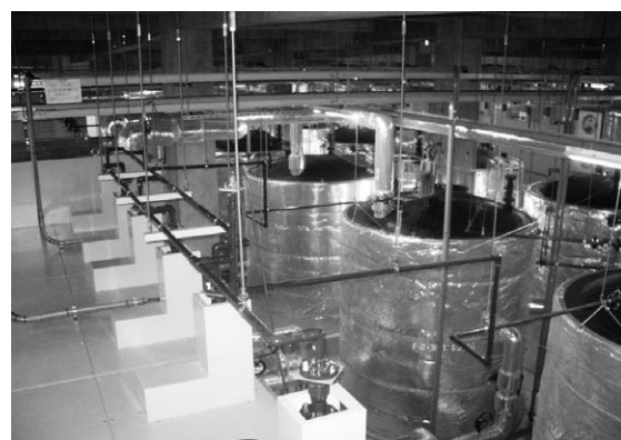
写真6 風力発電併設6MWシステム電解液タンク
