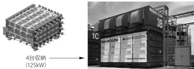
写真2 新型セルスタックと電池盤外観
