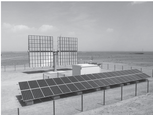
写真2 ワルザガートに設置したシステム(奥が20kW級のCPV、手前が10kWの固定Si-PV)
