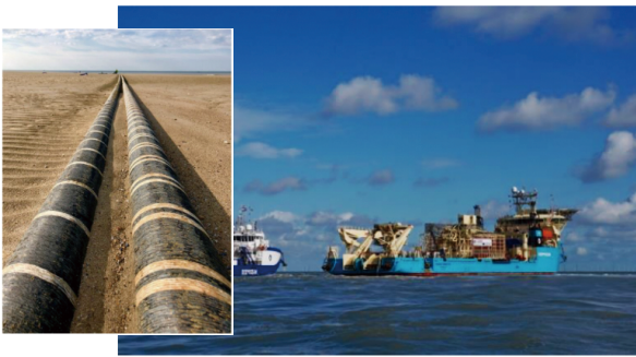
写真2 渚部に布設されたケーブルと布設船
