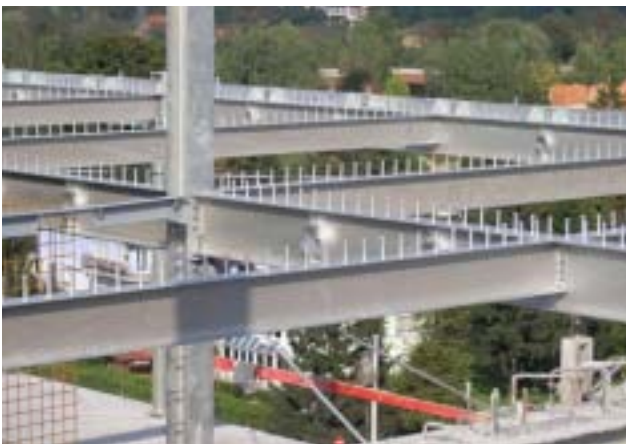
Slika 3. Primjer zavarenih svornjaka na nosećim gredama međukatne konstrukcije
