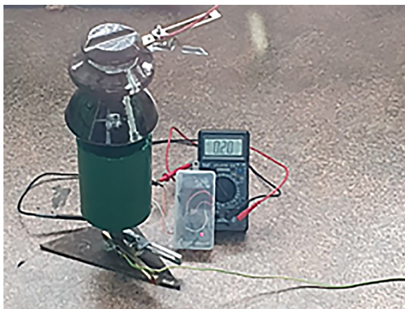
Рисунок 4 – Рабочее состояние диагностического устройства при поврежденном изоляторе
