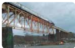
鉄道橋：山都町一ノ戸鉄橋
