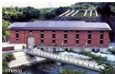
猪苗代第一発電所
