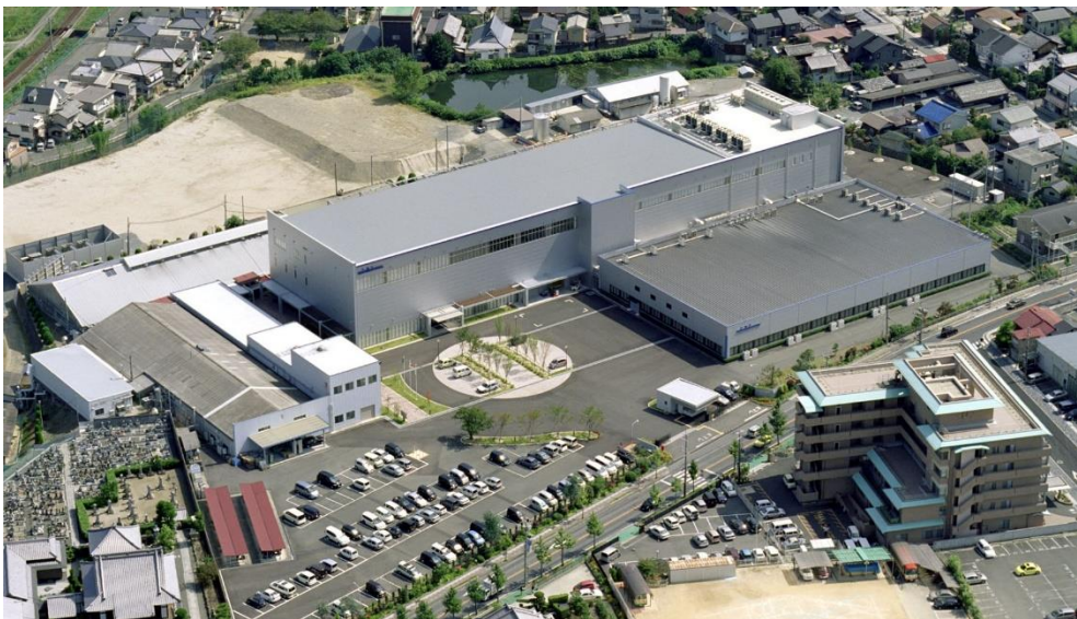
<本ローンの投資対象となっている、ニチコン亀岡>
